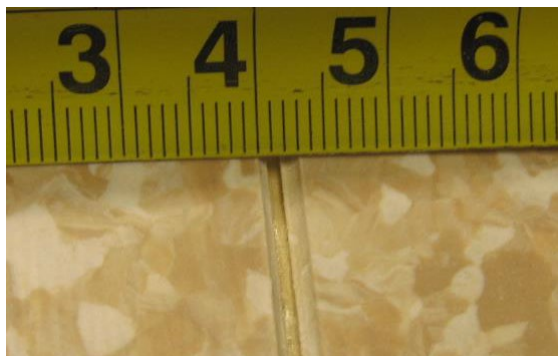
Zdjęcie prawidłowo wyfrezowanej szczeliny
